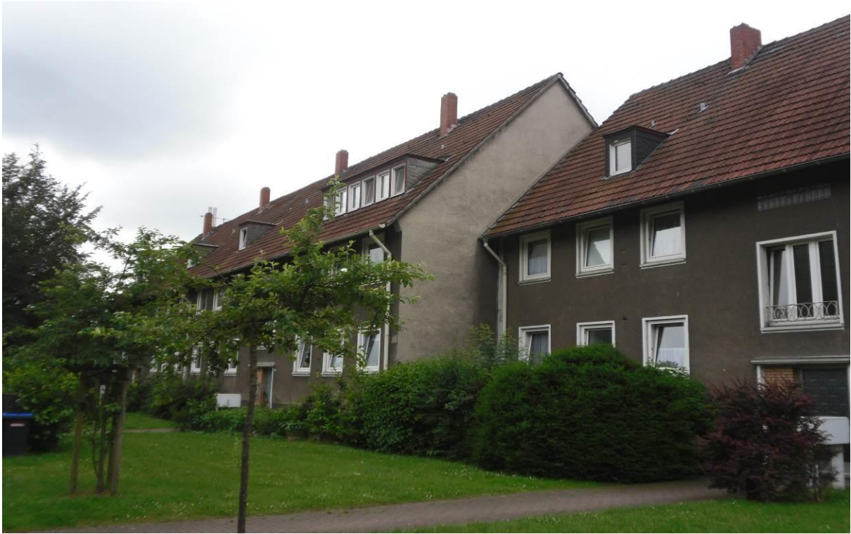
Abb. 2: Wohnblock Sudetenweg 2 in Hamm vor der Sanierung (Foto: Franco Cassese)
