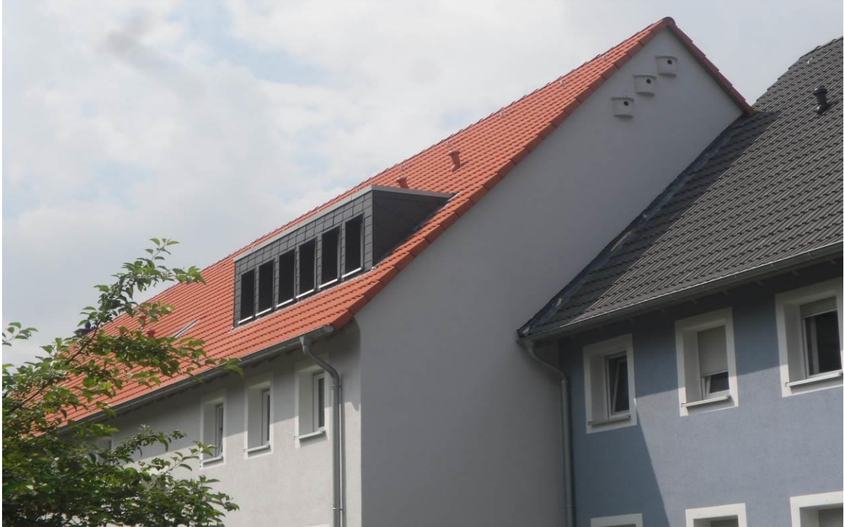
Abb. 3: Wohnblock Sudetenweg 2 in Hamm nach der Sanierung (Foto: Franco Cassese)
