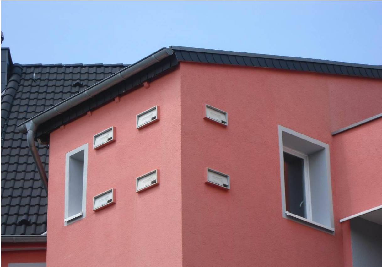
Abb. 4: Der Mauersegler-Einbaukasten16S ist aufgrund seiner Tiefe nur selten bündig einbaubar
