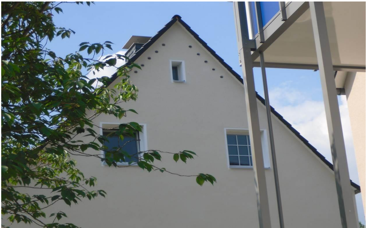
Abb. 2: Integration von zehn Mauersegler WDV-Einbaukästen 1A in eine gedämmte Fassade
