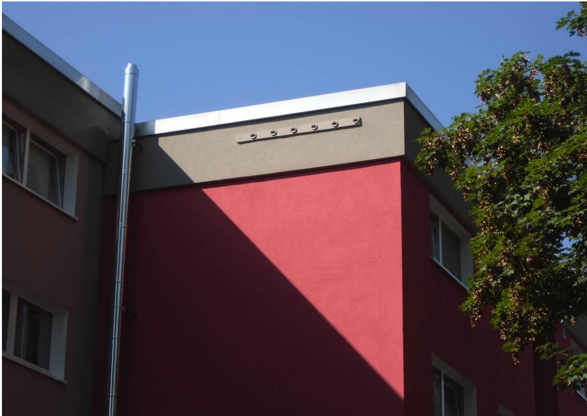
Abb. 3: Integration von sechs Mauersegler WDV-Einbaukästen 1A in eine gedämmte Fassade
