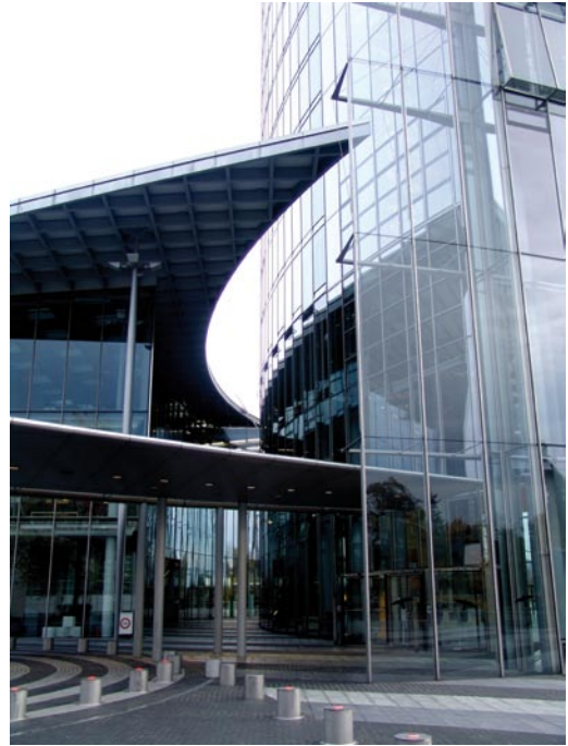
Abb. 3: Bereich des Haupteingangs am Post-Tower hinter der „wing wall“ (rechts), die sich an beiden Seiten entlang der gesamten Höhe des Gebäudes befindet. Links im Bild das Sockelgebäude mit der zum Turm hin gebildeten Passage. Ansicht von Westen.
