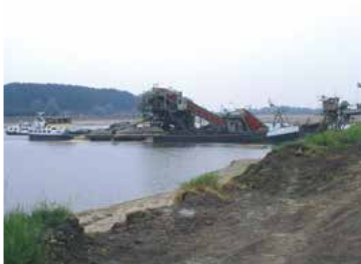
Abb. 7: Kiesabgrabung in einem Teilbereich der Reeserward in den 1990er Jahren.
