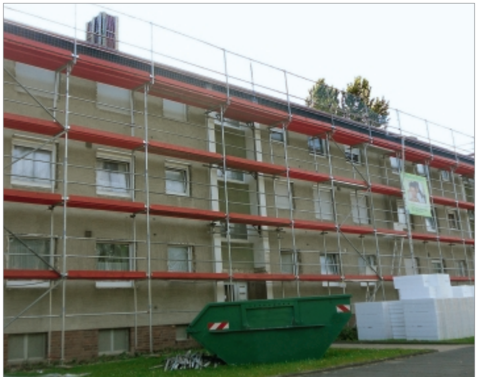
Abb. 1: Vor dem Anbringen der Wärmedämmung zur energetischen Gebäudesanierung werden Simse und Nischen entfernt und alle Ritzen und Löcher verschlossen.
