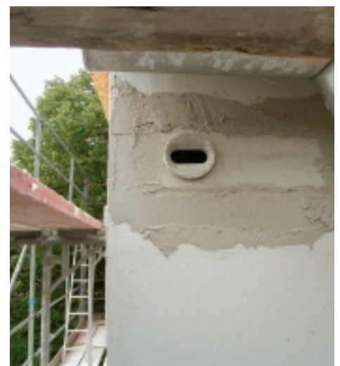
Abb. 3: Im Rahmen einer energetischen Gebäudesanierung neu geschaffener Brutplatz für den Mauersegler.
