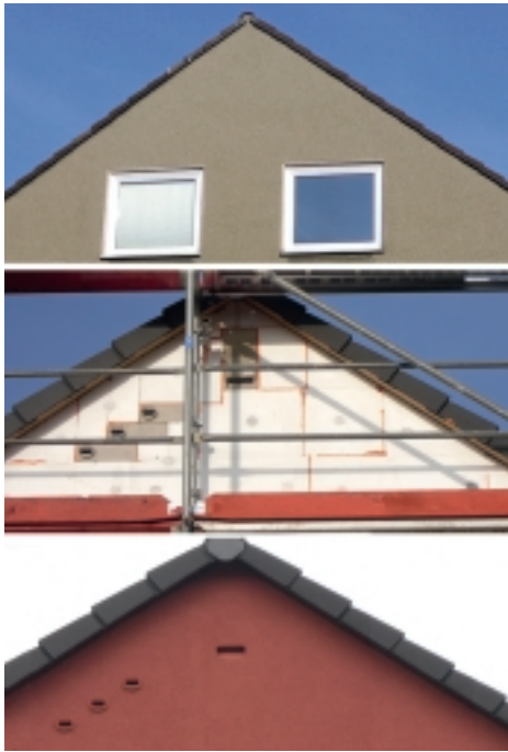
Abb. 4: An Siedlungshäusern in Hagen-Helfe werden im obersten Giebelbereich Brutmöglichkeiten neu geschaffen. Oben: Ausgangssituation ohne Brutmöglichkeiten, Mitte: In das WDV-System integrierte Nisthilfen kurz vor dem verputzen, Unten: Drei Mauerseglerbrutplätze und ein Fledermausquartier fertig integriert.
