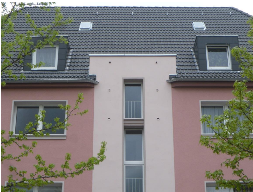
Sechs in die Wärmedämmung integrierte Mauerseglerkästen in Essen (© Franco Cassese)
